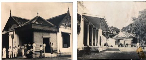
Gambar 15. Bangunan Tua di Situs Sumber: Dokumen Yayasan Pangudi Luhur
