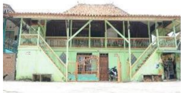
Gambar 5. Rumah Limas di Kampung Arab Balakja (Sumber: Dokumentasi Pribadi)
