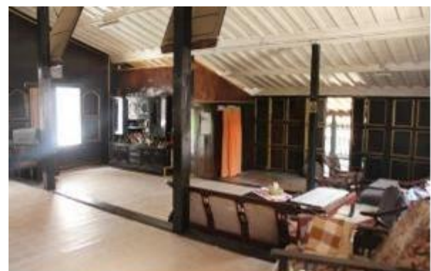
Gambar 7. Penggunaan material kayu pada struktur atap, kolom, lantai, jendela, dan pintu pada rumah limas Kampung Firma (Sumber: Dokumentasi Pribadi )
