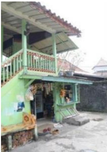
Gambar 6. Kolong Rumah Limas di Kampung Arab Balakja (Sumber: Dokumentasi Pribadi )
