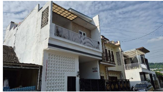
Gambar 8. Pengembangan vertikal & pemanfaatan roster pada fasad rumah P3 Sumber: Data Pribadi, 2025
