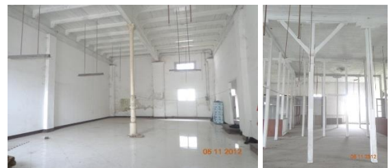
Gambar 11: Kiri – Kontruksi lantai satu, Kanan – Kanan – konstruksi lantai dua (Sumber: Dokumentasi penulis, 2024)
