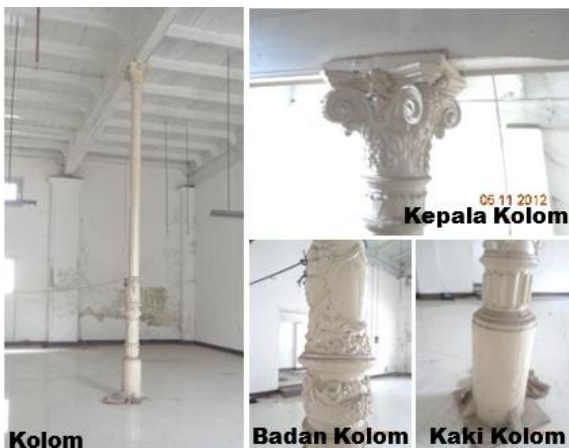
Gambar 19: Detail kolom besi corah penyangga plat lantai 2 (dua) (Sumber: Dokumentasi penulis, 2012)
