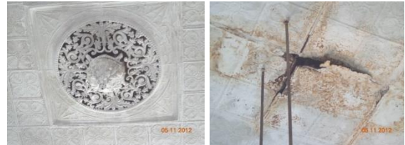
Gambar 20: Plafon lantai 2 (dua) menggunakan bahan dari metal (Sumber: Dokumentasi penulis, 2024)
