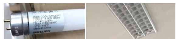
Gambar 2. Jenis lumener (kiri) yang terpasang dalam armatur (kanan) ruang kuliah. (sumber : penulis, 2024)
