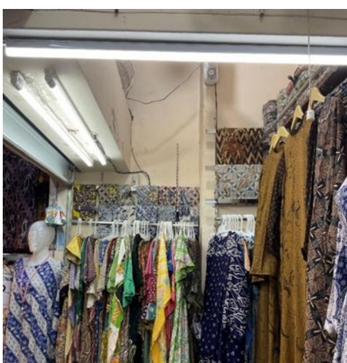
Gambar 11. Penempatan Linear Tube Kios D di Bawah Kotak Rolling Door dan di Bawah Buka-an Kios antar Kapling (Sumber: Dokumentasi Penulis)
