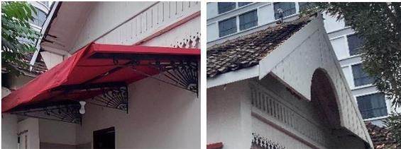
**Gambar 7: Kanopi dengan konsol logam dan Tutup keong & srawing**
