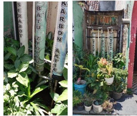
Gambar 12. Instalasi Pengelolaan Air Limbah di Kampung Lawas Maspati Sumber: Maharlika (2023)
