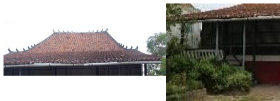
Gambar 23: Atap Dan Tiang Penopang Atap (Sumber: Dokumentasi Penulis, 2017)
