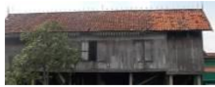
Gambar 39: Fasad Dinding (Sumber: Dokumentasi Penulis, 2017)
