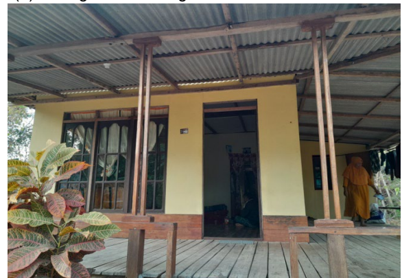
(c) Lantai bangunan menggunakan papan (kayu)
