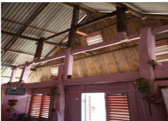
(a) Atap bangunan menggunakan seng. Jendela dan dinding menggunakan papan (kayu)
