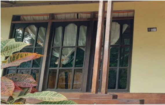
(e) Jendela bangunan menggunakan kayu
