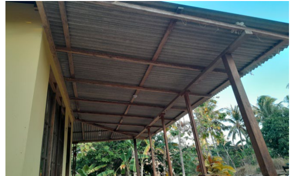
(a) Atap bangunan menggunakan seng
