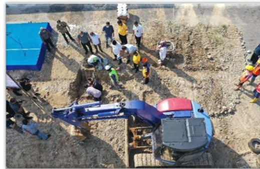
Gambar 7 Dokumentasi pada minggu ke-1 proses pembangunan Gedung Kantor Permanen-Pembangunan Gedung Kebudayaan Tahun 2022
