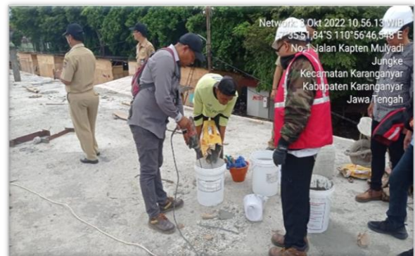
Gambar 8 Dokumentasi pada minggu ke-16 proses pembangunan Gedung Kantor Permanen-Pembangunan Gedung Kebudayaan Tahun 2022
