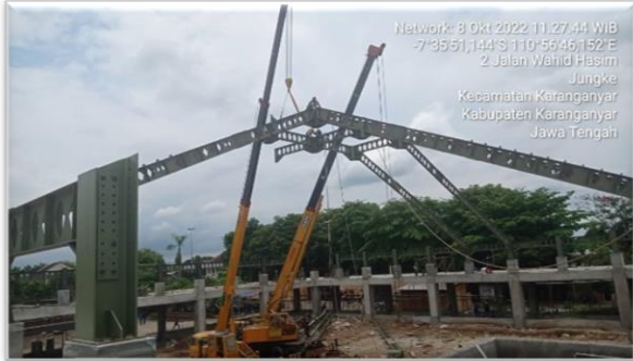
Gambar 16 Metode Perakitan Penggunaan alat Berat Atap Baja Pembangunan Gedung Kantor Permanen-Pembangunan Gedung Kebudayaan
