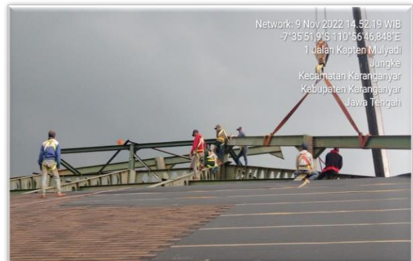
Gambar 14 Pengecekan Metode kerja Perakitan Atap Baja Pembangunan Gedung Kantor Permanen-Pembangunan Gedung Kebudayaan
