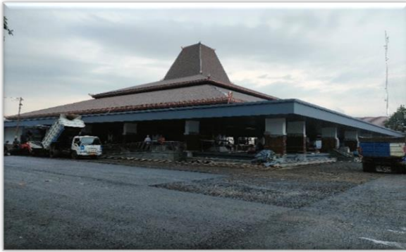
Gambar 9 Dokumentasi pada minggu ke-28 proses pembangunan Gedung Kantor Permanen-Pembangunan Gedung Kebudayaan Tahun 2022
