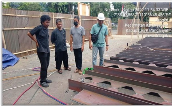
Gambar 11 Pengecekan Mutu Sambungan Baja Pembangunan Gedung Kantor Permanen- Pembangunan Gedung Kebudayaan
