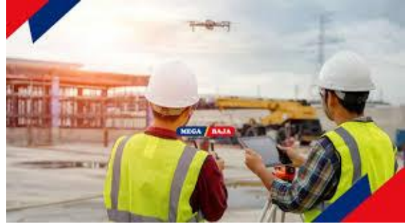
Gambar 3. Pengambilan gambar pada konstruksi dengan drone
