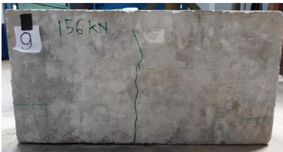
Gambar 16. Pola Retak Pada Balok Beton Monolit
